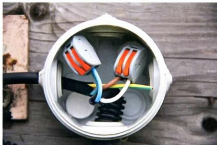
Проводники соединены рычажными клеммными колодками.
