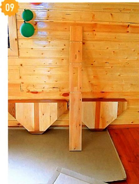
Проделал в доске сквозные отверстия для прокладки проводов, под вилки и блок розеток удлинителя. Собрал этажерку всухую, примерил её к штатному углу. После разборки и подгонки боковых кромок полок по месту приступил к отделке деталей прозрачным лаком на водной основе. Очень пригодились листы от картонной упаковки.
