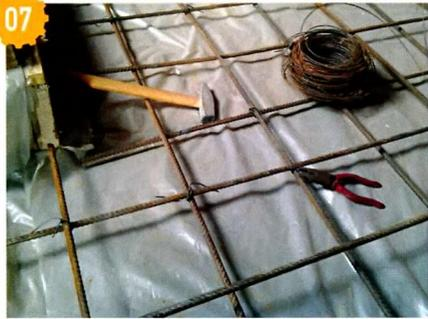
07 На настил из досок под опалубку уложил полиэтиленовую плёнку, поверх которой смонтировал арматурный каркас.
