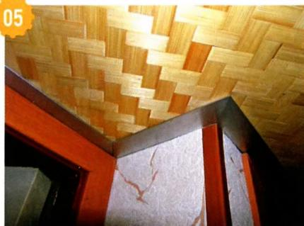
05 При оформлении границ панели из рогожки, внешних и внутренних углов стен использованы ламинированные ПВХ-раскладки и угловые профили.
