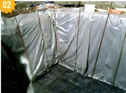
Стены котлована покрыли полиэтиленовой пленкой, на дно положили рубероид и арматурную сетку.
