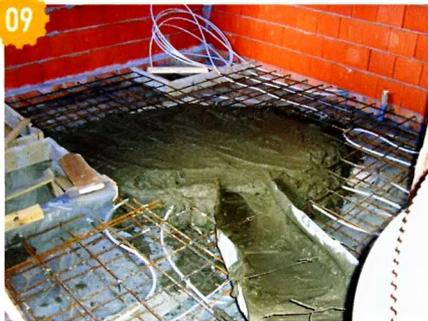
09 Укладка бетона в перекрытие погреба.
