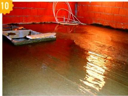
10 Бетонирование перекрытия выполнил за один день.
