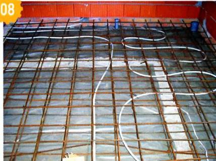
08 Между прутками арматурного каркаса уложил трубы тёплого водяного пола.
