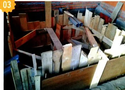
При изготовлении опалубки для стен в дело пошли б/у доски и панели ДСП.
