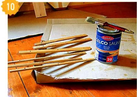
Фиксирующие дубовые рейки по длине боковых кромок полок подготовил заранее так, чтобы крепёжные шурупы не попали в стыки шпунтованных досок обшивки стен.
