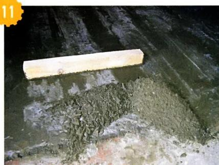
11 Утром следующего дня затёр поверхность плиты бруском и полил водой.
