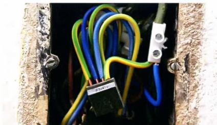
Проводники в коробке соединены винтовыми и пружинными клеммами.
