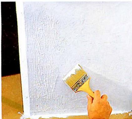
Рустикальную фактуру можно создать нанесением на загрунтованные поверхности так называемой структурной штукатурки, если наносить её широкой кистью движениями во взаимно перекрещивающихся направлениях. Поверхности можно оставить в таком виде, а можно покрасить их цветной краской для стен.
