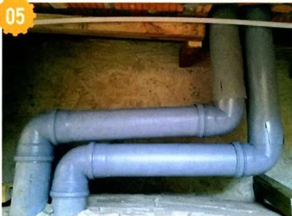
Для организации вентиляции погреба использовал пластиковые трубы и отводы.
